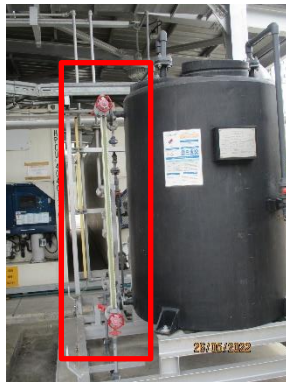
รูปที่ 57 อุปกรณ์วัดระดับ (Level Indicator) ของสารเคมีในถังเก็บ และสัญญาณเตือน (Level Alarm)
