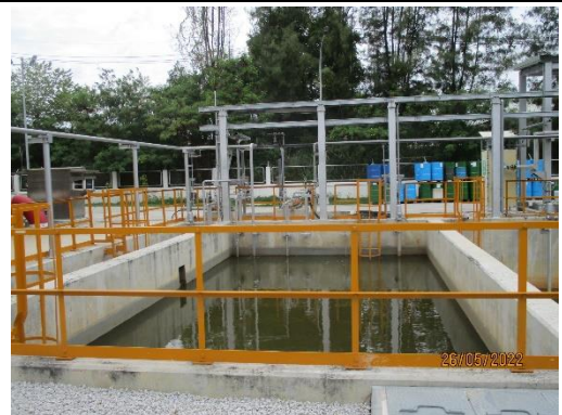
รูปที่ 17 บ่อพักน้ำระบายทิ้งจากหอหล่อเย็น (Cooling Water Blowdown Hold Sump)
