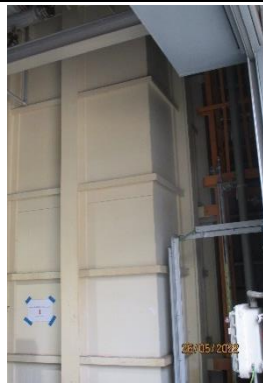
รูปที่ 16 บ่อรวบรวมน้ำเสียที่มีความเข้มข้นของ มลสารสูง (POP/Premix High Polluted Wastewater Pit; HPW Pit)
