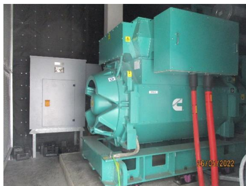
รูปที่ 55 ระบบไฟฟ้าสำรอง
