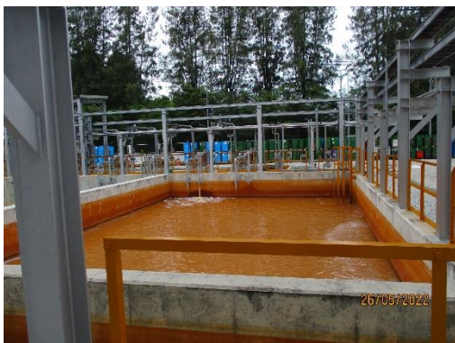
รูปที่ 18 บ่อรับน้ำเสียฉุกเฉิน (Emergency Wastewater Retention Basin)
