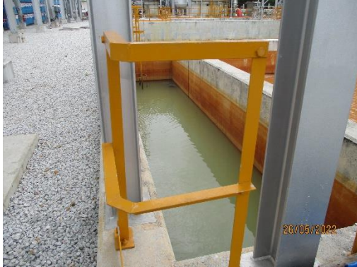
รูปที่ 20 หน่วยแยกน้ำมัน (Oil Separator)
