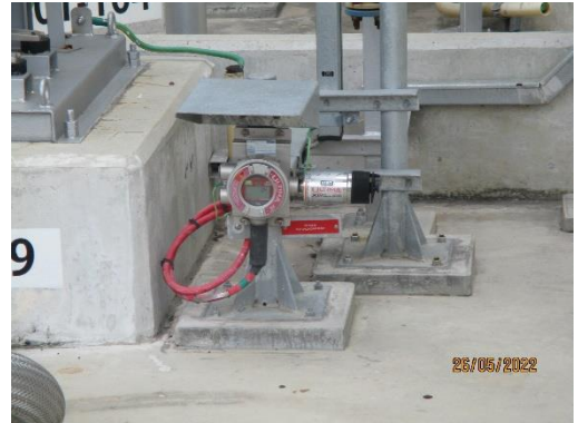
รูปที่ 48 Toxic Gas Detector บริเวณอุปกรณ์การผลิต ที่เกี่ยวข้องกับเอทิลีนออกไซด์
