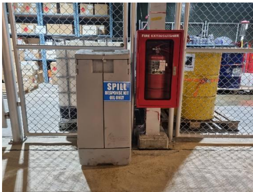
รูปที่ 40 อุปกรณ์ในการระงับเหตุฉุกเฉินกรณีเกิดการรั่วไหลในบริเวณอาคารรวบรวมกากของเสียอุตสาหกรรม
