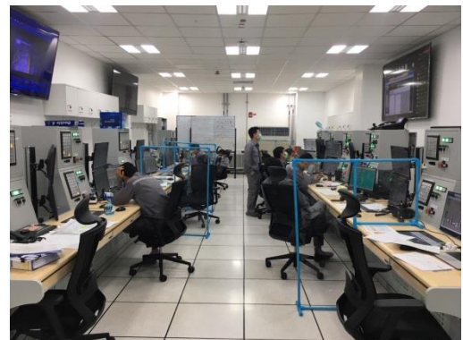
รูปที่ 54 ระบบ Distributed Control System (DCS)
