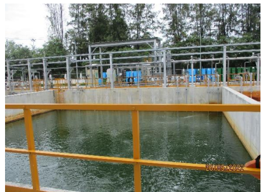
รูปที่ 19 บ่อพักน้ำเสียสุดท้าย (Final Check Basin)
