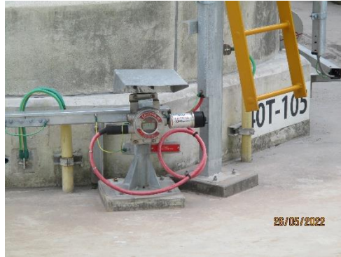
รูปที่ 60 อุปกรณ์ตรวจจับก๊าซ (Gas Detector)
