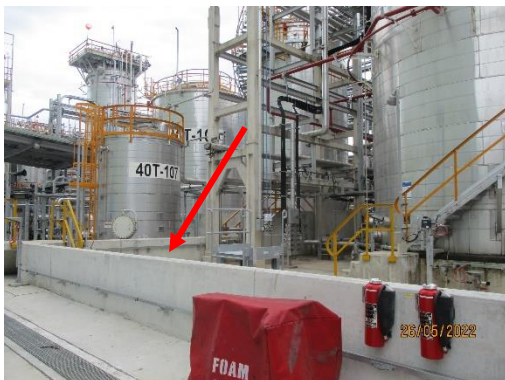
รูปที่ 53 คันกัน (Bund) ล้อมถังเก็บสารเคมี
