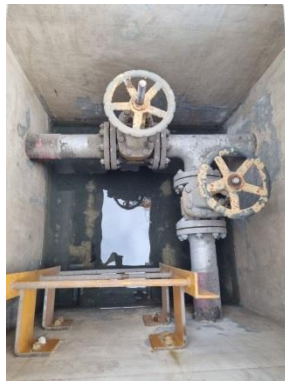
รูปที่ 26 Valve Pit
