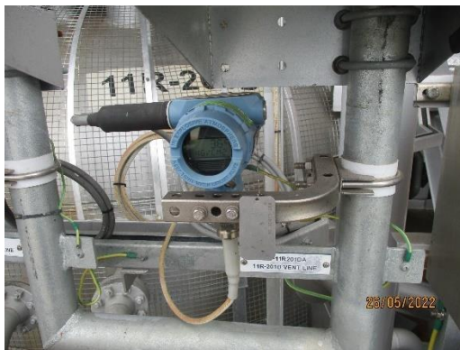
รูปที่ 61 ระบบวัดอุณหภูมิและความดันภายในถังปฏิกิริยาพลีเอตชนิด PPG (PPG Reactor)
