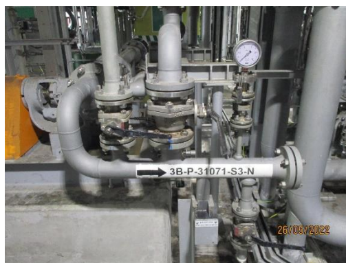
รูปที่ 59 ระบบ Isolate Valve บริเวณอุปกรณ์สูบลำ
