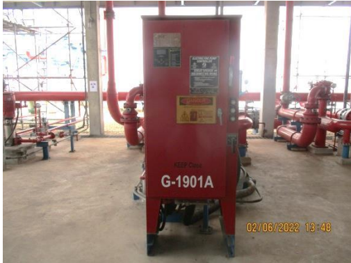
รูปที่ 51 เครื่องสูบน้ำดับเพลิง (Electric Motor Driven Fire Water Pumps)
