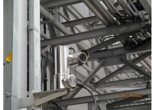
รูปที่ 56 โทรศัพท์วงจรปิด (Closed Circuit Television)
