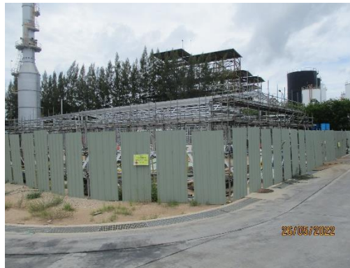
รูปที่ 3 วัสดุกันรอบพื้นที่ก่อสร้าง
