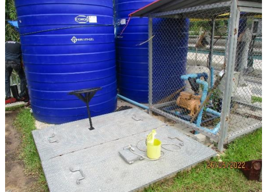
รูปที่ 21 บ่อตรวจสอบคุณภาพน้ำ (Inspection Pit) บริเวณท่อระบายน้ำเสีย
