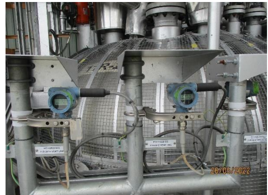
รูปที่ 61 ระบบวัดอุณหภูมิและความดันภายในถังปฏิกิริยาพลีเอตชนิด PPG (PPG Reactor)
