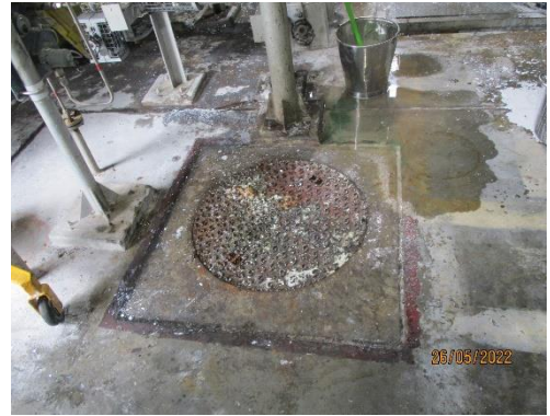
รูปที่ 15 บ่อรวบรวมน้ำเสียที่มีความเข้มข้นของ มลสารต่ำ (POP/Premix Low Polluted Wastewater Pit; LPW Pit)
