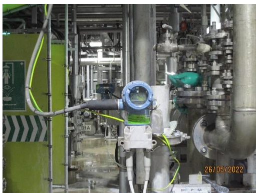
รูปที่ 62 ระบบวัดอุณหภูมิและความดันภายในถังปฏิกิริยาพลีเอตชนิด POP (POP Reactor)
