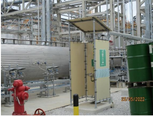
รูปที่ 46 อ่างล้างตาและร่างกาย กรณีฉุกเฉิน
