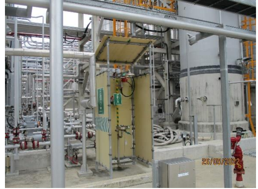
รูปที่ 46 อ่างล้างตาและร่างกาย กรณีฉุกเฉิน
